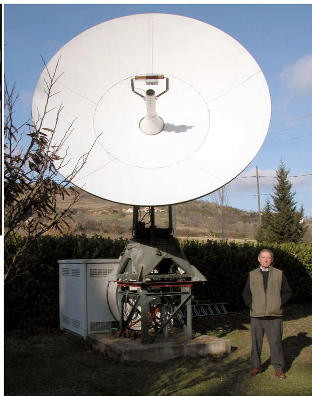
En plus de cela, Bertrand possède tout l'équipement que l'on a l'habitude de trouver dans les stations ESTRACK, comme une source corruguée, un polariseur et un amplificateur à faible bruit. Tout cela a été construit par Bertrand, acheté par lui ou lui a été donné pour assembler sa station.
