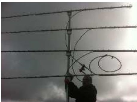
Montage des antennes 1296MHz
