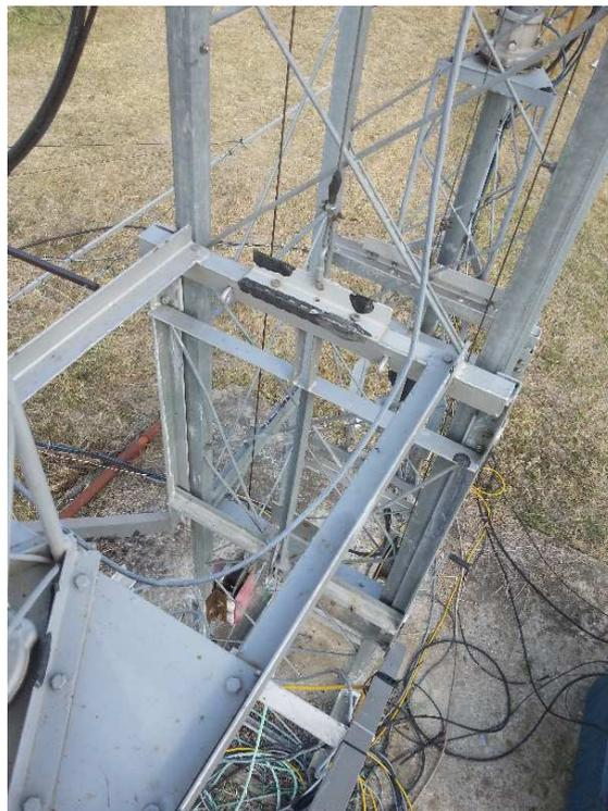
Le positionnement en azimut s'effectue avec un rotor Spid et l'élévation avec un vérin satellite classique. L'articulation du système d'élévation utilise des roulements. La réalisation a nécessité l'usinage de quelques pièces au tour et à la fraiseuse.
